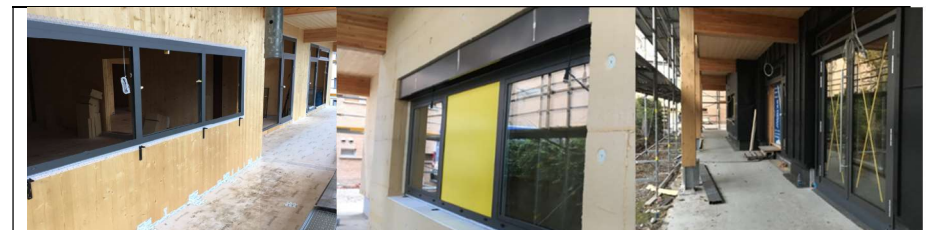
Fenster- Außentüren EG Süd
