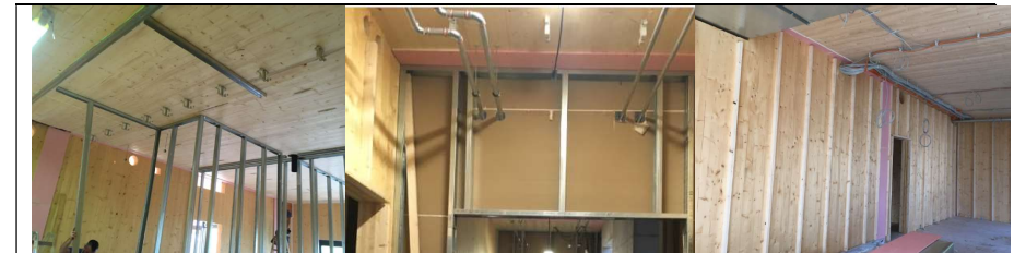
Montage Blechrahmen und Klemmleisten Installation Wasserrohre Verkabelung Einzelräume
