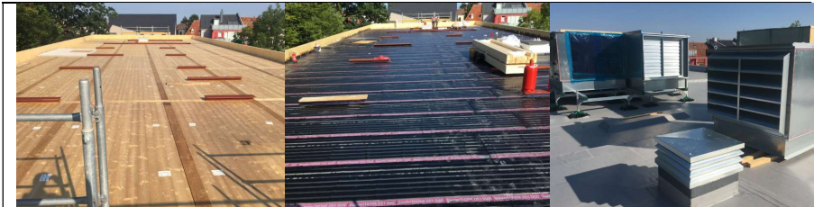
Holzdach mit Stahlträger Verstärkung
