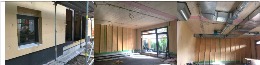
Holzbau Außendämmung EG Trockenbau und Brandschutz Ausbau Lüftung OG
